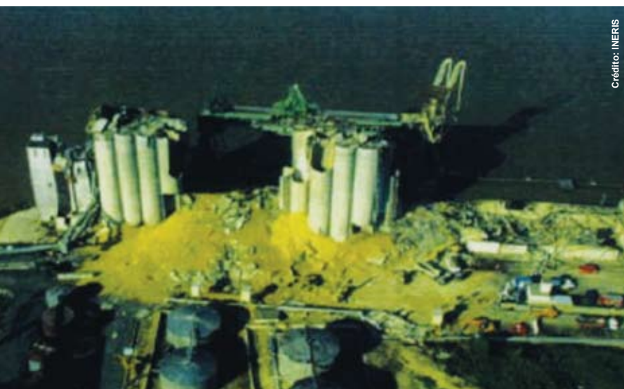
Figura 1: Imagem após explosão nos silos. Blaye – França 1997.
